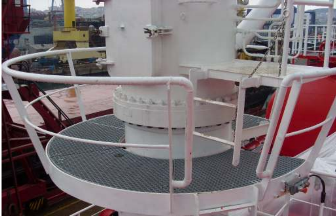
• Vinç Platform uygulaması
